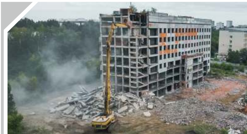
Экскаватор-demolition CAT 385C (длина стрелы 45 метров)
