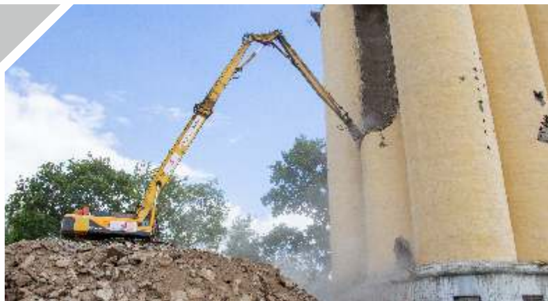
Экскаватор-demolition Hyundai 520 (длина стрелы 31 метр)
